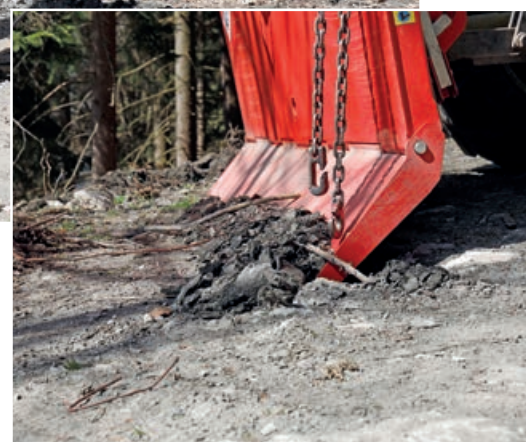
Der Bewegungsbereich des hydraulischen Stützschildes ist leider gering.
