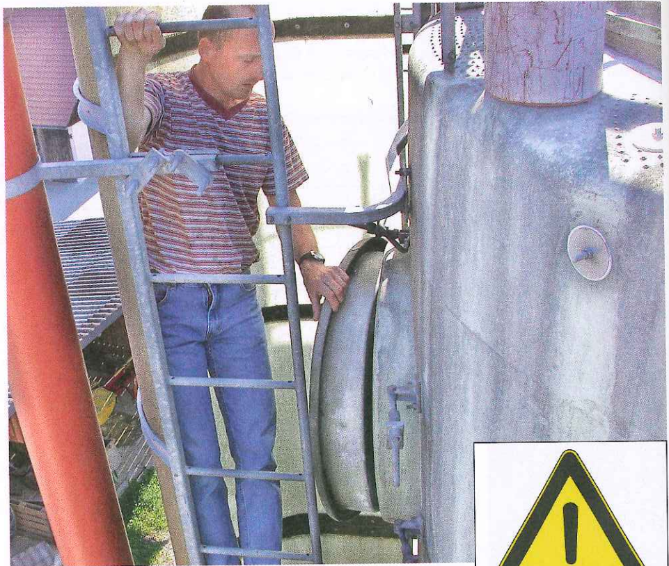
▲ Da Kohlendioxyd nach unten fällt, müssen Sie beim Öffnen der Silotüren nach oben wegsteigen. Fotos: SVB
